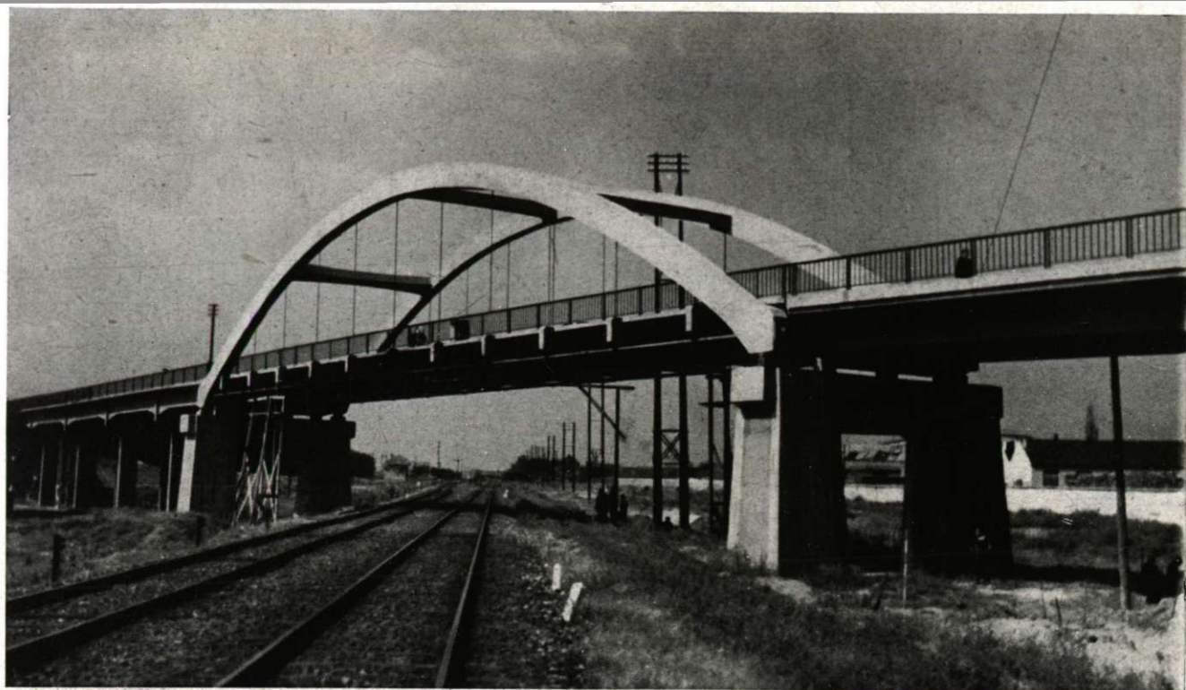
A MÁV ceglédi vasútvonalának áthidalása.
