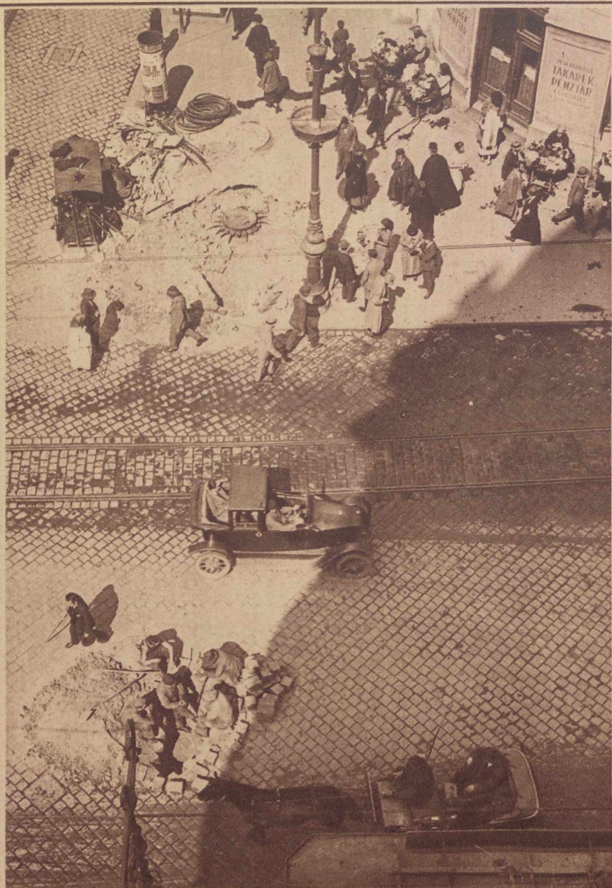
Érdekes felvétel a Rákóczi-út és a Nagykörút sarkáról, ahol a kábel-munkások felbontották az úttestet
