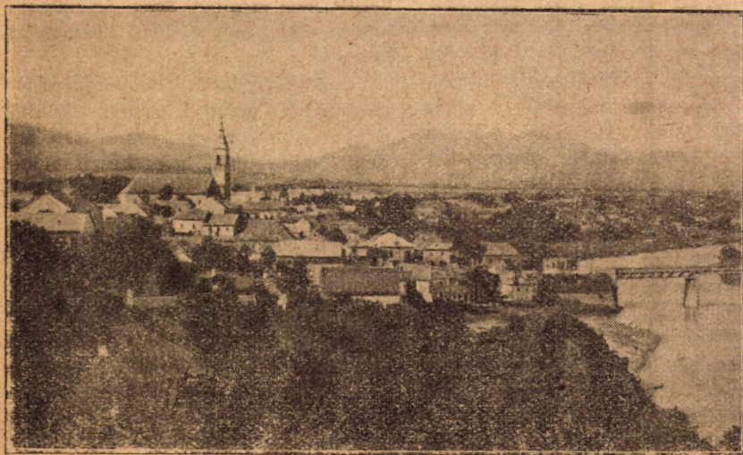
Sárospatak látképe a Bodrog folyó felől nézve.
