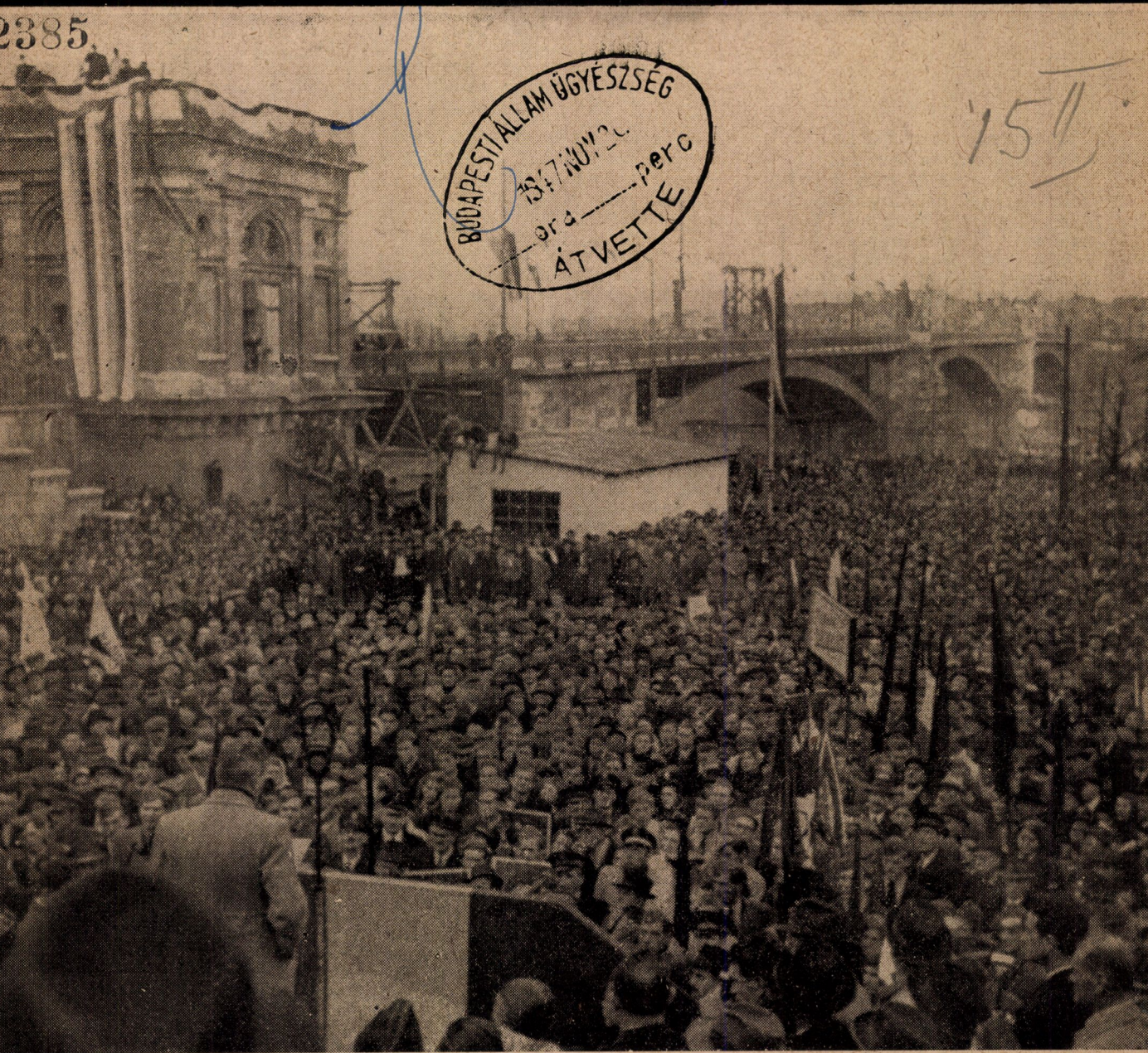
Cerő: A Margithíd újjáépítése, nagy együttes munka eredménye
