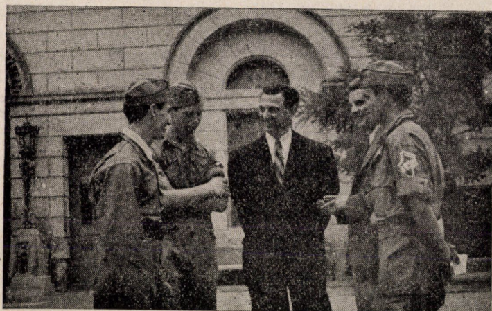
Boarov Zsivko sajtóattasé szívélyes beszélgetésben az ifjúsági vasútvonal építési munkálataira induló Vasvári-brigád vezetőivel
