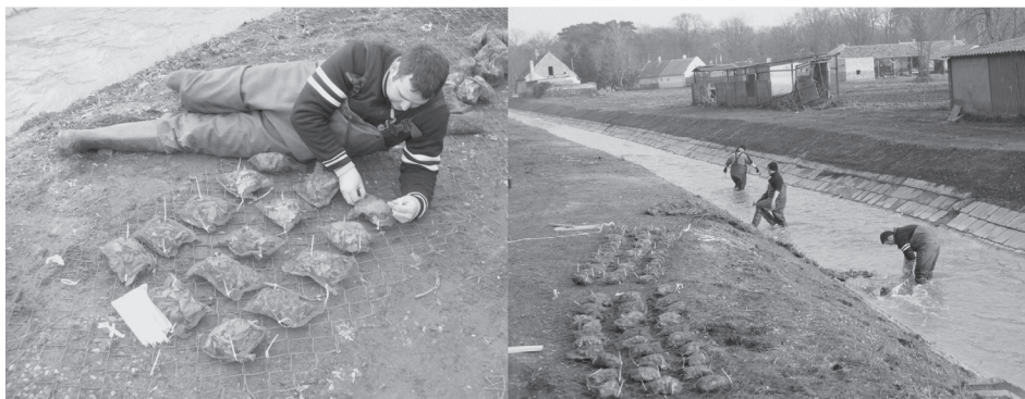
3. ábra. Avarzsákok rögzítése rácra és a rác rögzítése a patakmederhez
