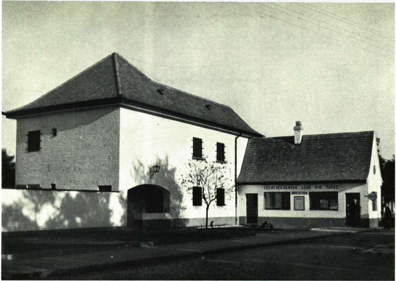
Székesfehérvár. Vámház és vámőrlakás. A főútvonalra néző homlokzat.
