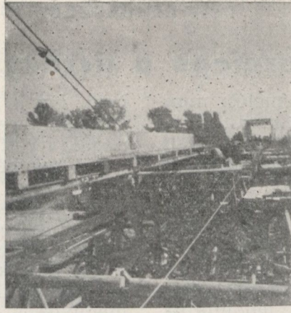
5. számú ábra. Az alsó övek behúzása
