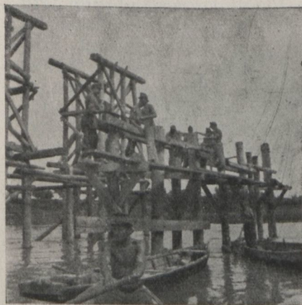
1. számú ábra. Szerelőjármok építése
